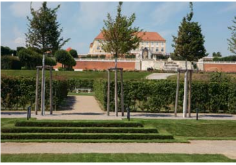
Detail der rekonstruierten siebten Gartenterrasse
