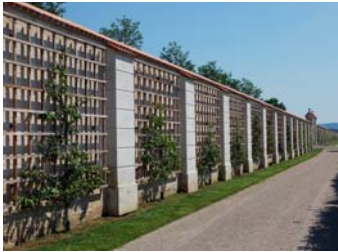
Holzspaliere für Obstbaumpflanzungen an der Umfassungsmauer
