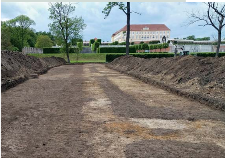
Bodenabtrag mit gartenarchäologischen Spuren auf der siebten Gartenterrasse
